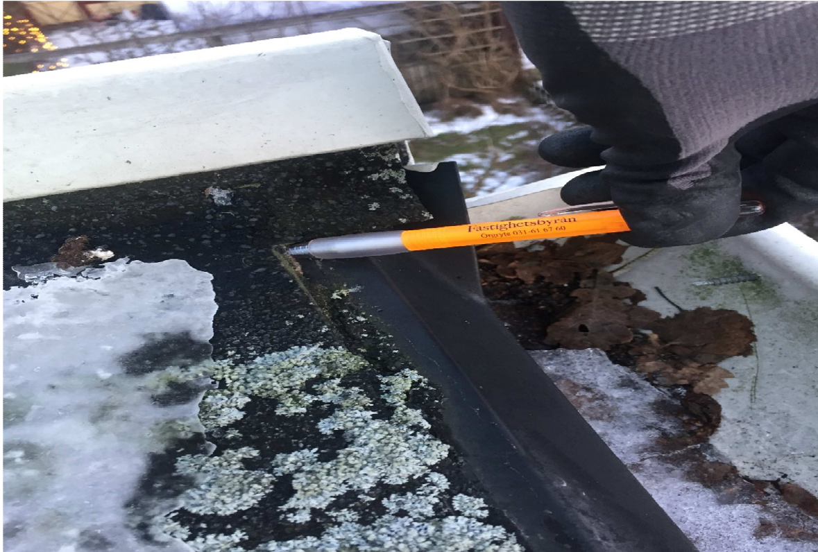
Pappen har släppt i anslutningen mot fotplåten på hus nr 44. Detta är en stor läckage risk som bör åtgärdas. Går att åtgärda enl förslaget till bild 7. Detta är bild 8.
