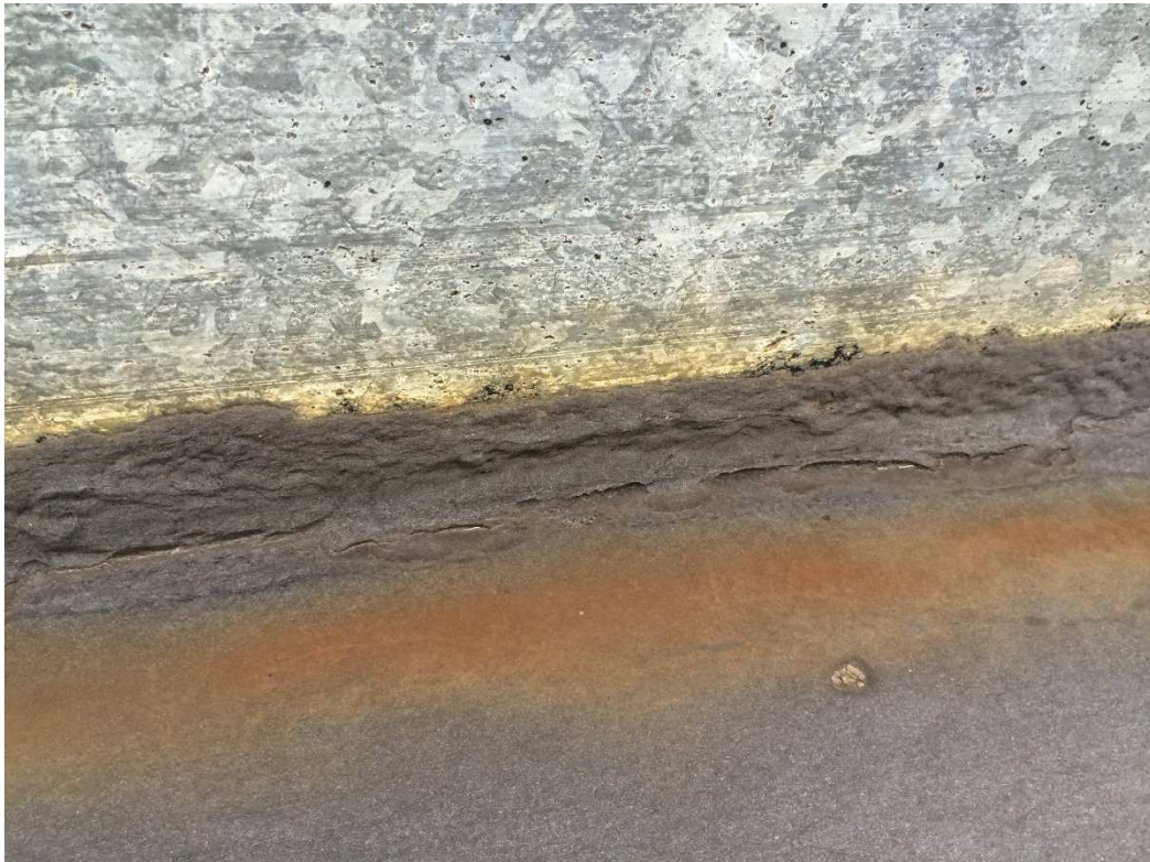
Denna bild tillhör länga 300-310. Generellt är att taket är stryket med tak massa. Det har inte gjorts några intäkningar på huvar eller takfönster. Det har börjat spricka vid anslutning mellan tak massa och plåtbeslag. Detta är bild 18.
