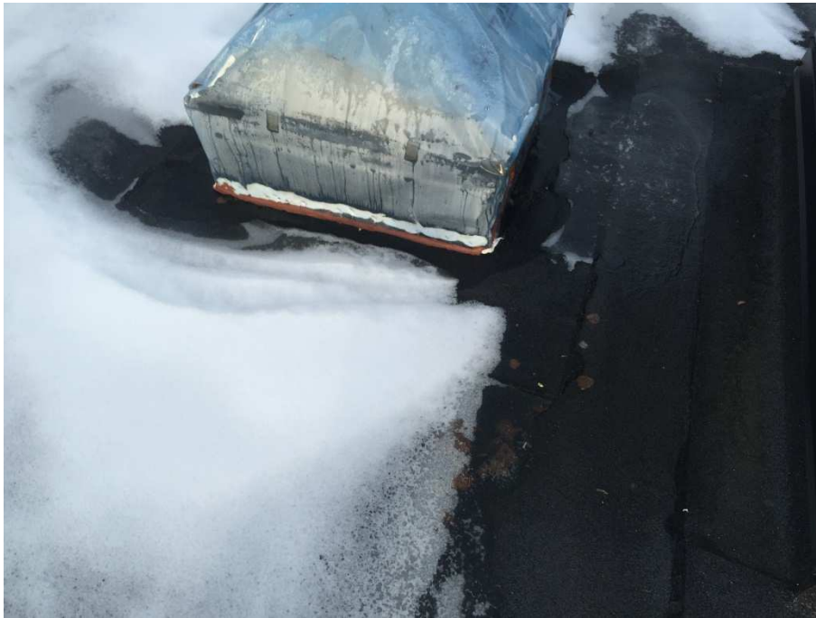
Takfönster på hus nr 181 är intäkt med plastfolie som är fogat mot pappen. Bytas ut till nytt takljus eller täckas in på nytt?! Detta är bild 15.
