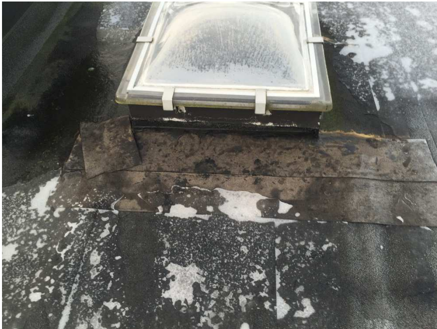
Takfönster på hus nr 115 är åtgärdat med underlagspapp och tak massa. Huv bör täckas in med papp. Läckagerisk. Detta är bild 10.
