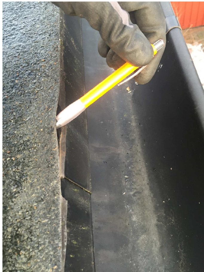
Pappen har släppt mot fotplåten. Detta är en stor läckagerisk och bör åtgärdas snarast med ny fotplåt och papp. Detta är bild 5.
