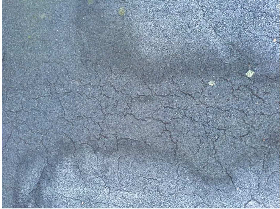
Sprickbildningar på takytans tätskikt. Detta är ett tecken på att taket snart behöver läggas om. Detta är Bild 4.
