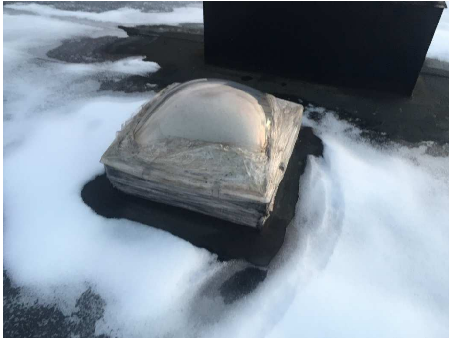
Takfönster på hus nr 21 är intäkt med plast. Detta är bild 6.
