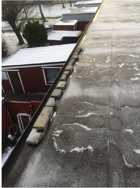
Det ligger stenar vid fotplåten på hus nr 118. Detta är bild 12.
