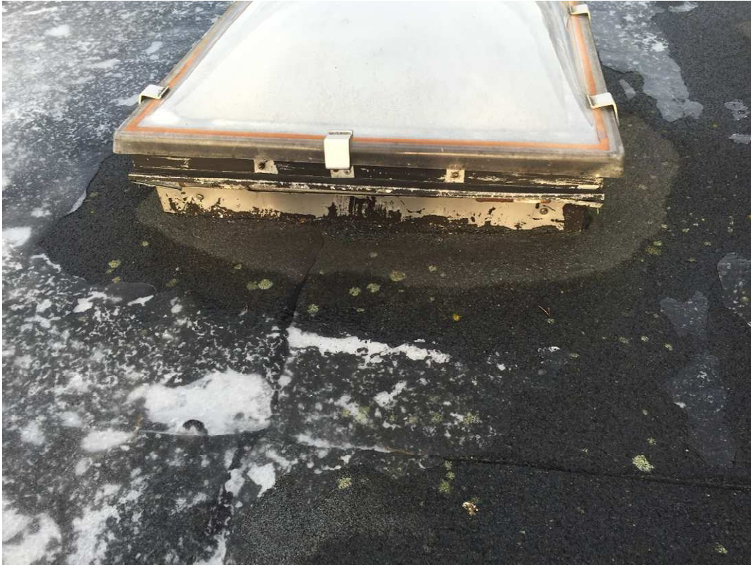
Takfönster på hus nr 243 är ej intäkt. Går att åtgärda enl förslag till bild 7. Detta är bild 17.
