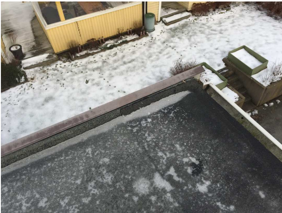
Kronplåten närmast hänggränsen håller på att lossna på hus nr 192. Denna behöver skruvas fast så den inte riskerar att lossna vid blåst och skada någon/något. Detta är bild 14.
